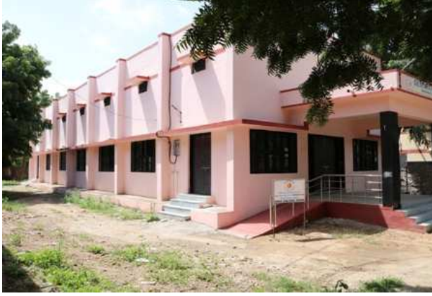
(मुख्य परिसर में भव्य सेमीनार हॉल का निर्माण)
